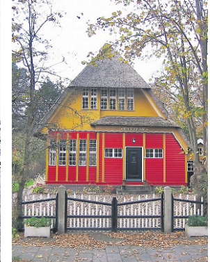
Siervilla Het Hoge dak aan de Koningin Julianaalaan in Oranjewoud.
